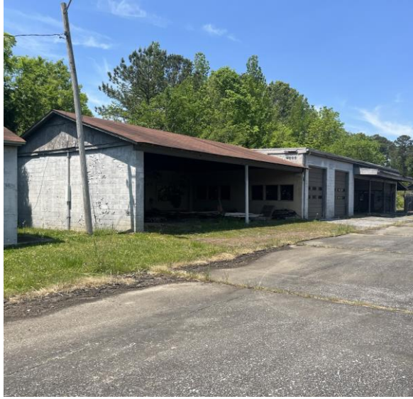
Antigua estación de mantenimiento de automóviles / gasolinera
